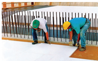
PROMATECT®-T použitý jako ztracené bednění
