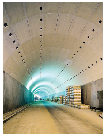
Obklad tunelového tělesa ohýbanými deskami PROMATECT®-H
