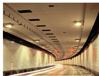
Tunel s obkladem v provozuschopném stavu
