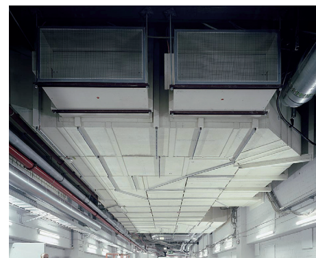
Příklad vodorovného potrubí pro odvod kouře a tepla PROMATECT® – L 500, EI multi 60
