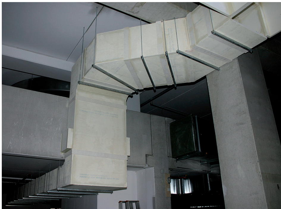
Příklad potrubí pro odvod kouře a tepla PROMATECT® – L 500, EI multi 30
