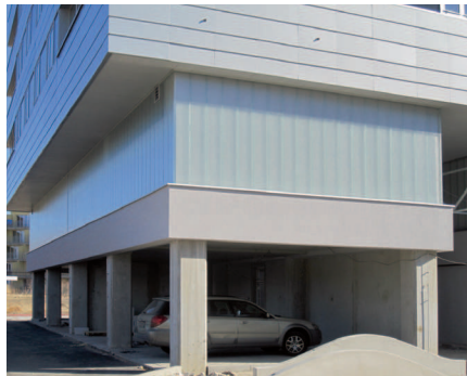
Obr. 4, 5 Profilové sklo v časti technického podlažia
