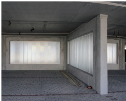
Obr. 6 až 8 Profilové sklo v stenách oddelujúcich vstupné priestory od garážového státi
