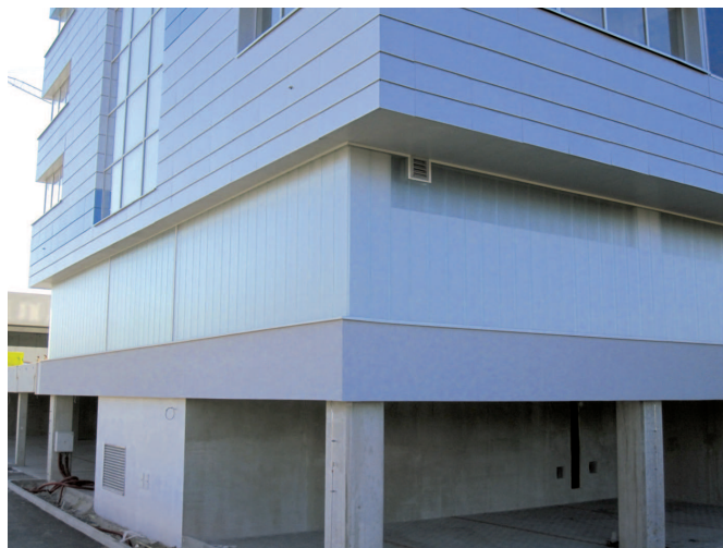
Obr. 3 Schodisková stena kombinovaná s metalickým obkladom
