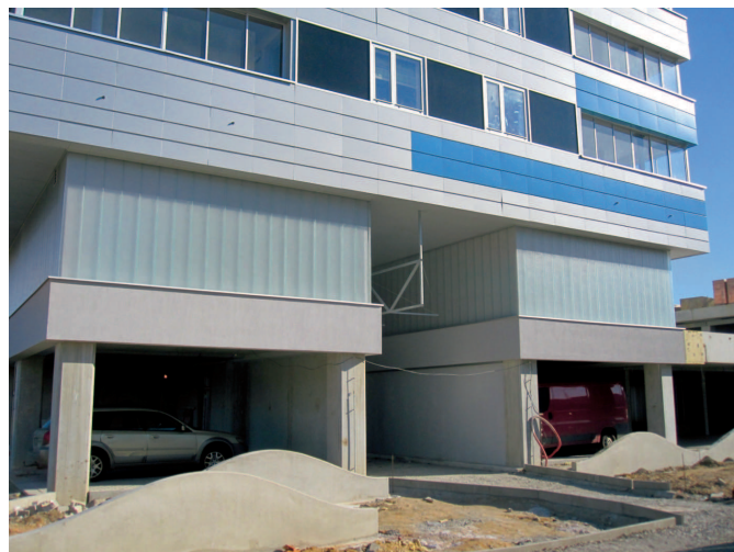
Obr. 2 Kombinácia sklených pásov, zasklených rohových terás a metalického kazetového obkladu
