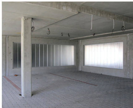
Obr. 6 až 8 Profilové sklo v stenách oddelujúcich vstupné priestory od garážového státi
