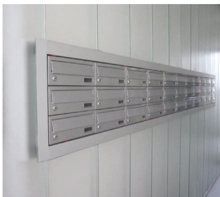
Obr. 9 Osadenie poštových schránok do steny z profilového skla
