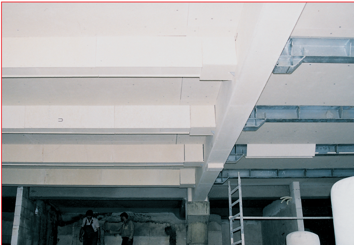
Obklad ocelových konstrukcí požárně ochrannými deskami PROMATECT®
