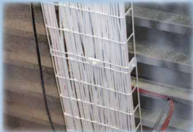
Příklad provedení nástřiku kabelové trasy materiálem PROMASTOP®, typ K
