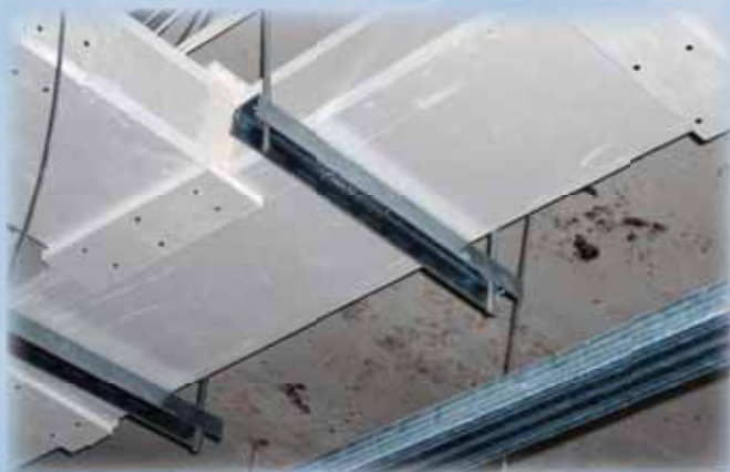
Příklad provedení kabelového kanálu třídy funkčnosti P30-R
