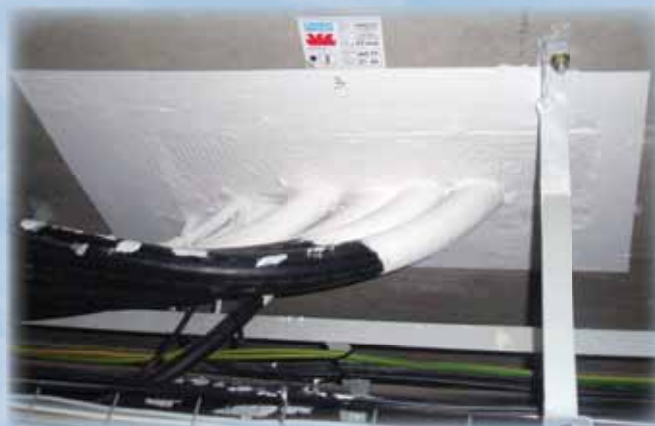
Detail deskové přepážky PROMASTOP®, typ P, EI 60
