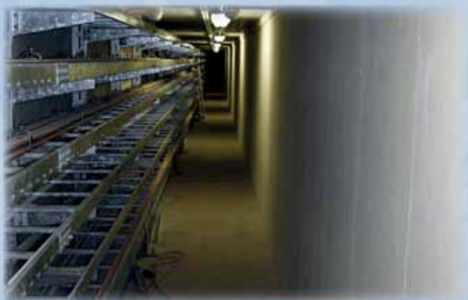
Příklad oddělení jednotlivých kabelových systémů svislou příčkou PROMATECT®-H
