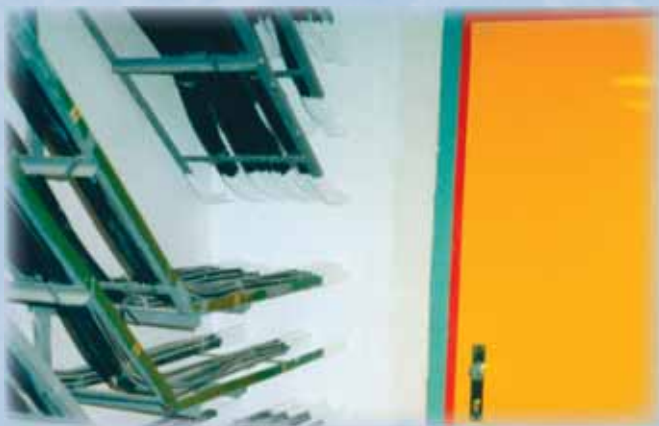
Hlavní přepážka v kabelovém kanálu s kabelovou přepážkou PROMASTOP®
