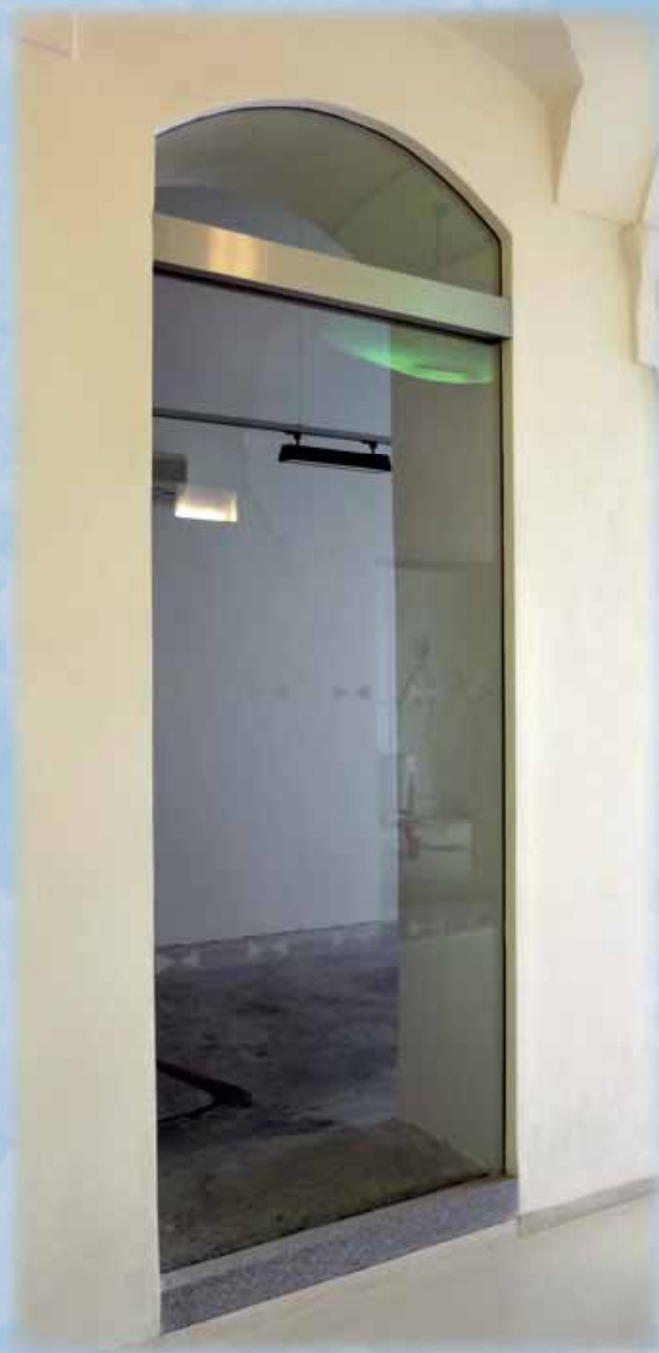
PROMAGLAS® - lehká stavební konstrukce EI 45
