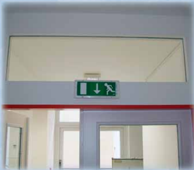
PROMAGLAS® - lehká stavební konstrukce EI 30 – nadsvětlik nad dveřmi
