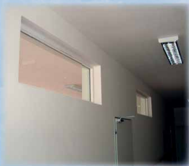
PROMAGLAS® - lehká stavební konstrukce EI 30 – prosvětlení chodby
