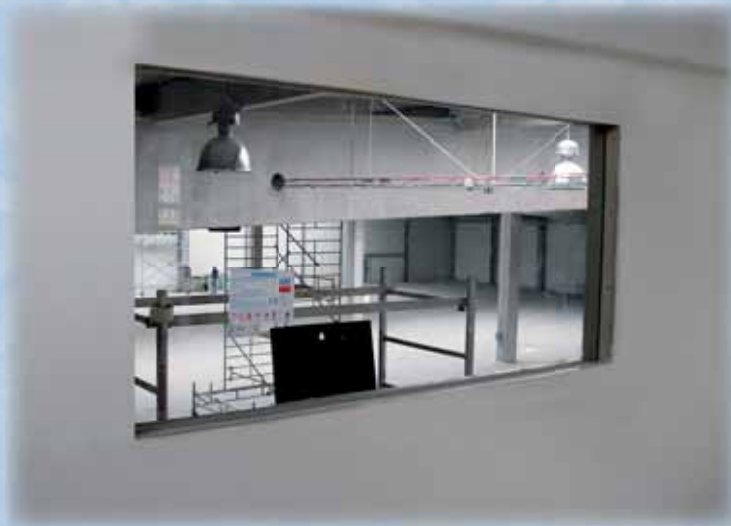
Lehká stavební konstrukce PROMAGLAS® EI 30 – osazení do lehké přičky
