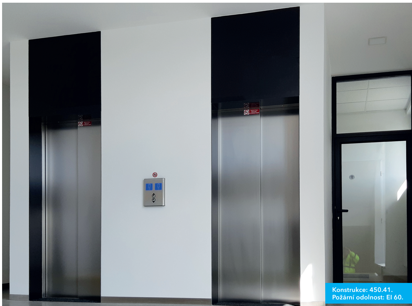
Konstrukce: 450.41. Požární odolnost: EI 60.
